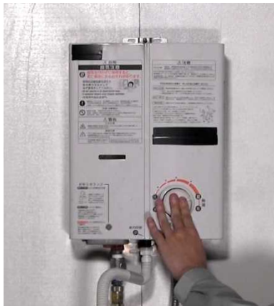
写真1. ガス瞬間湯沸器に未燃ガスが滞留して、異常着火
